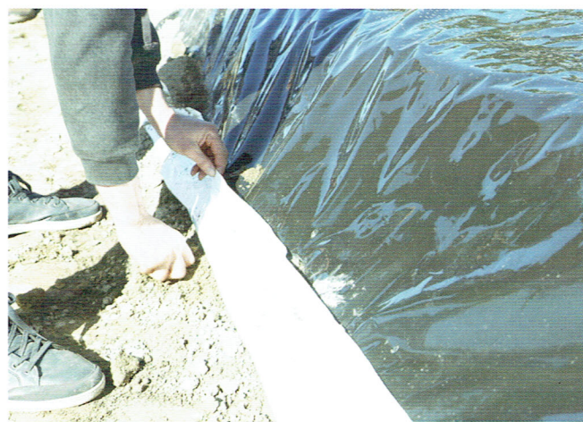
Przykrywanie wałów czarno-białą folią. W rękawie znajduje się ziemia zapobiegająca zwiewaniu folii.
